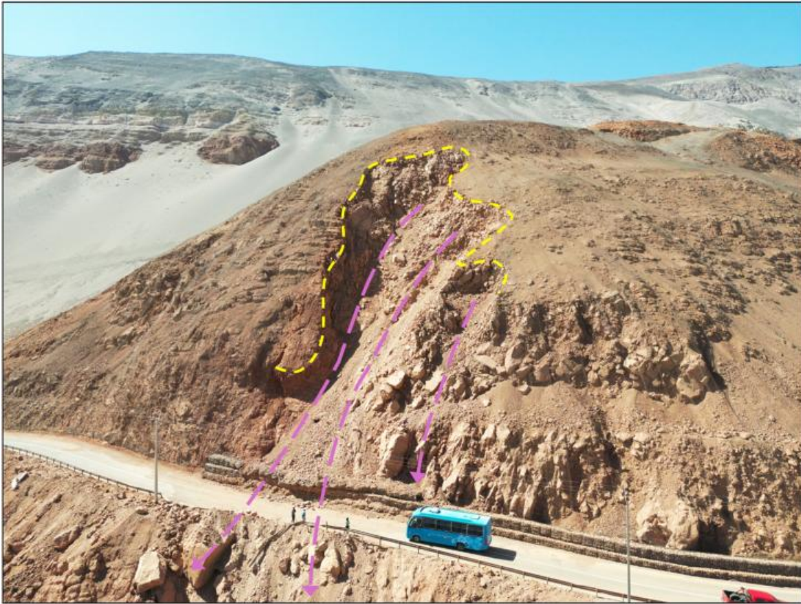
Fig. 41 Ejemplo de deslizamiento en la ruta A-345 (flechas moradas esquematizan dirección de movimiento del material deslizado; línea segmentada amarilla señala el escarpe). ID_RM: 15150239 (400243E, 7896315S)
