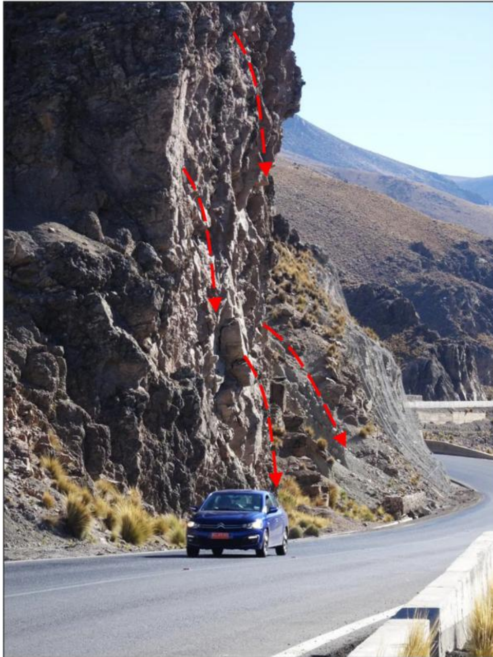
Fig. 36 Ejemplo de caída de rocas en ruta 11-CH (esquematzada con líneas rojas). Archivo de terreno. ID_RM 15121149 (447412E, 7990723S).
