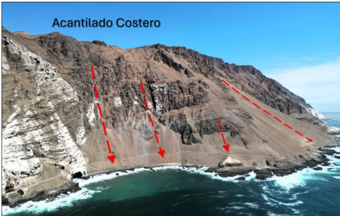
Fig. 122 Altas pendientes del Acantilado Costero que genera caída de rocas (flechas rojas). Sector sur Cuevas de Anzota (coordenadas 359357E;7947958S). Archivo de terreno. Mapa de relieve de sombreado (Hillshade)
