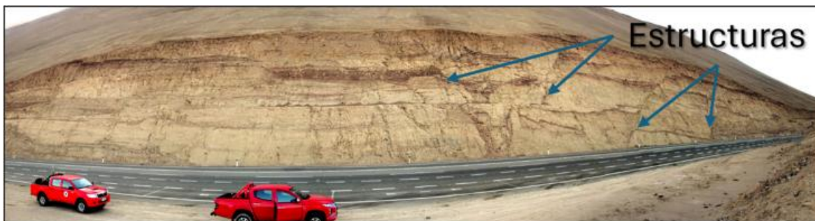
Fig. 12 Talud artificial de ruta 5 norte (sector cuesta de la cultura Chinchorro, coordenadas 381954,20 E / 7887826,66 S) evidenciando un fuerte control estructural. Archivo de terreno.
