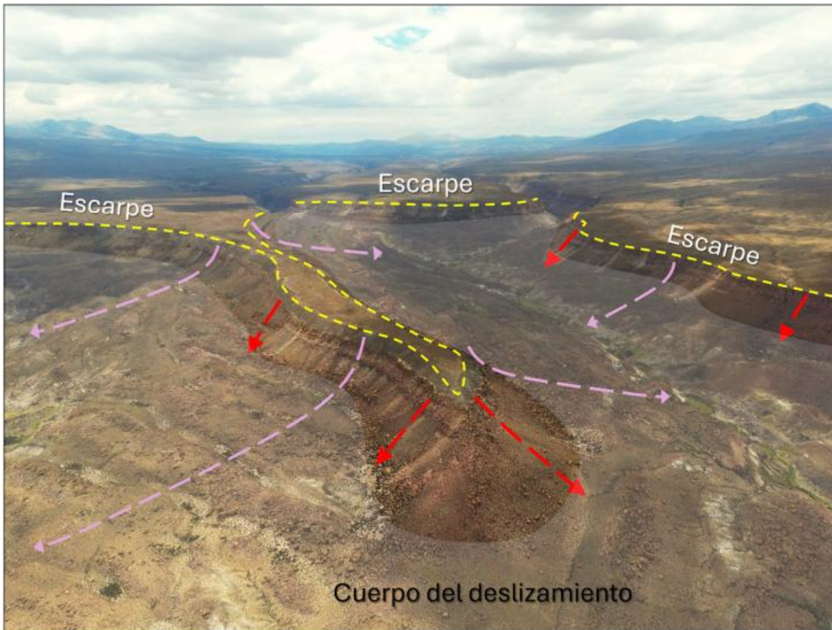
Fig. 9 Reactivación de remociones en masa. Comportamiento inicial de deslizamiento rotacional (flechas moradas) secundado por caída de rocas (flechas rojas) en escarpes del deslizamiento. Archivo de terreno. Sector ruta A-23 entre Putre y Coronel Alcérreca (coordenadas 433826E;8010928S).
