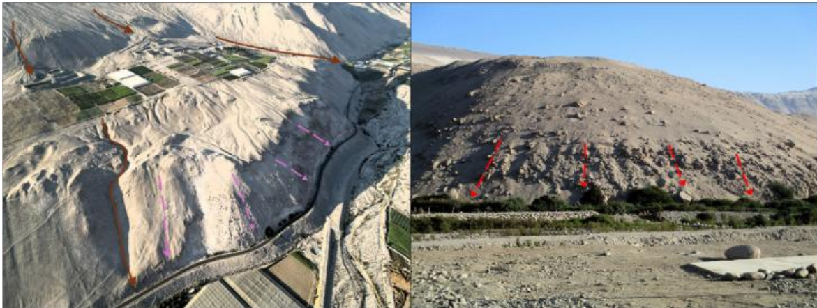
Fig. 33 Ejemplo de caídas de rocas desde laderas de valle del río San José. Archivo de terreno (las flechas moradas indican ejemplo de trayectoria de deslizamientos; las flechas cafés indican flujos y flechas rojas indican caídas). Fotografía izquierda: ID_RM 15130440 (398381E; 7945750S) e ID_RM 15130419 (399026.28E; 7947780.87S), ladera norte valle del río San José (ruta A-27). Fotografía derecha: ladera sur valle de río San José, ID_RM 15130562 (397924E; 7945592S).
