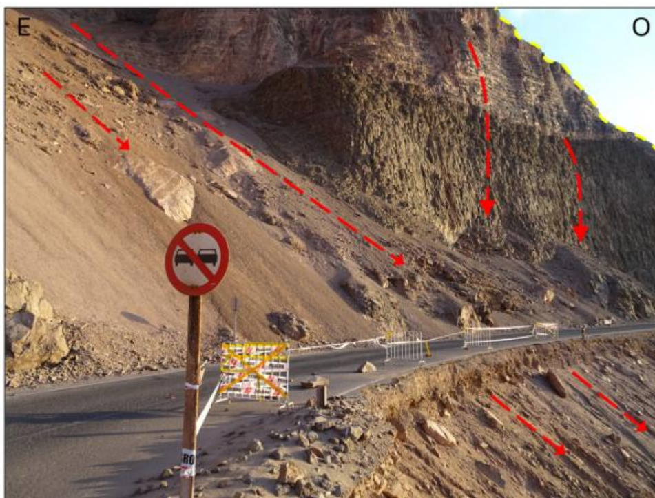
Fig. 98 Fotografía que muestra el acceso a las cuevas de Anzota, con evidencias de caídas y deslizamientos que han afectado la ruta (se ejemplifica con flechas rojas la dirección del material movilizado).
