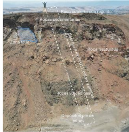
Figura 3-4 Modelo geológico – geotécnico sección 4 de análisis (zona de lavas en almohadillas y grietas).
