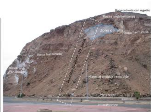
Figura 3-5 Modelo geológico – geotécnico sección 5 de análisis (zona de remoción en masa y zanja).
